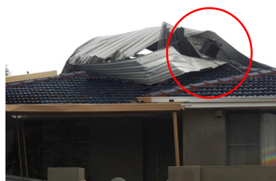
(d) Brick pillar on roof
