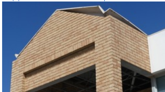
(d) Flashings not fastened
