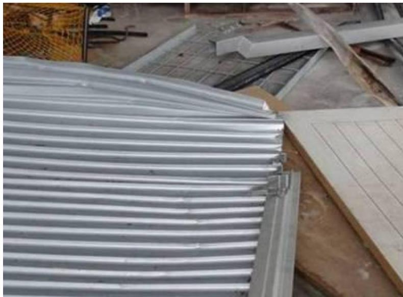
**Figure 3.28 Roller door guide failure**
